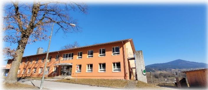
Außenstelle Bad Kötzting
